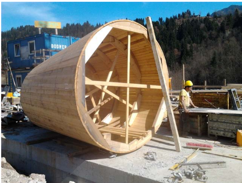
Nach der Druckprüfung wird die fehlende Verbindung hergestellt. Bild der Schalung
